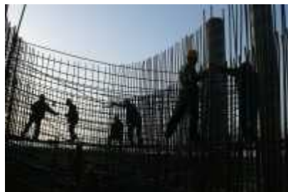
写真は京滬高速鉄道の河北省の建設現場。
